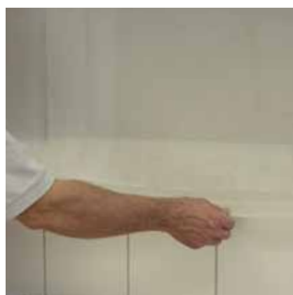
ambiente® Glasvezelvlies vouwen- en blaasvrij in de nog natte laag leggen. Onderelkaar moeten de banen ca. 5 cm overlappen.
