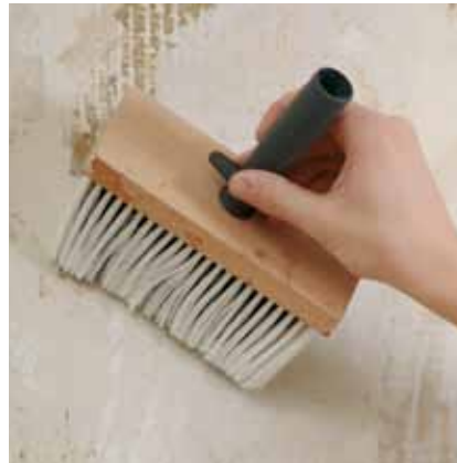
ambiente® Voorstrijk wordt met kwast op de ondergrond aangebracht – dit is noodzakelijk bij oude, beperkt draagkrachtige ondergronden voor het verstevigen van de ondergrond.
