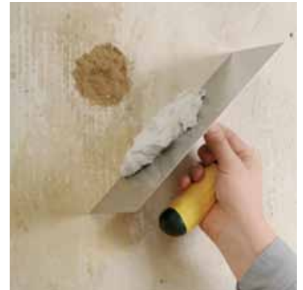
Beschadigingen zo noodzakelijk met Sopro Vulstuc Wit repareren.
