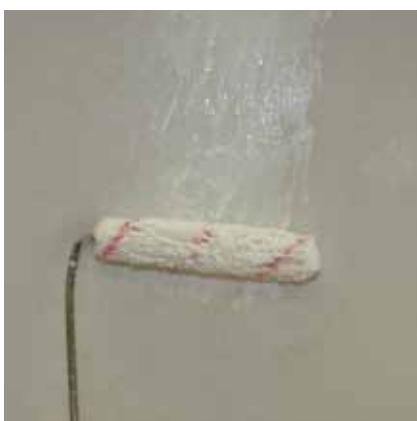
Voor 2–3 baanbreedtes ambiente® Glasvezelvlies moet ambiente® Glasvezellijm met de lamsvoller gelijkmatig op de ondergrond worden aangebracht.
