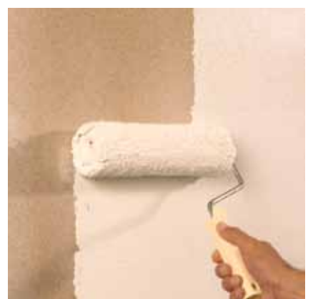
ambiente® Isolievoorstrijk in twee lagen met een lamsvoller aanbrengen. Aan te brengen in het geval er op de ondergrond verkleuringen (nicotine, teer, bitumen, etc.) te verwachten zijn.
