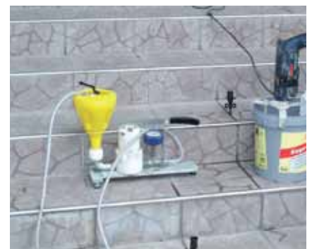
Persen van een holligende bedekking op een trap.
