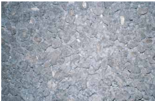
Poreuze cementdekvloer, met open poriën.
