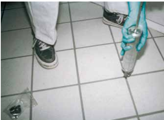
Injecteren met een handpers voor kleine vlakken.
